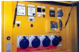
Baustromverteiler
